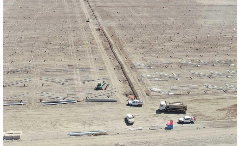
Limondale, Australia (найбільша в Австралії) 349 МВт
